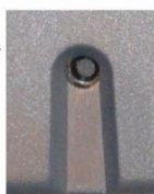
Ogranicznik temperatury ( STB ) przycisk RESET
